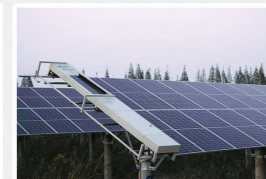
应用项目 上海渔光互补电站
