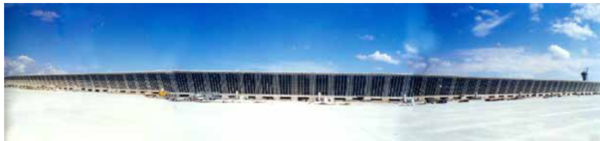
浦东机场登机长廊钢结构
