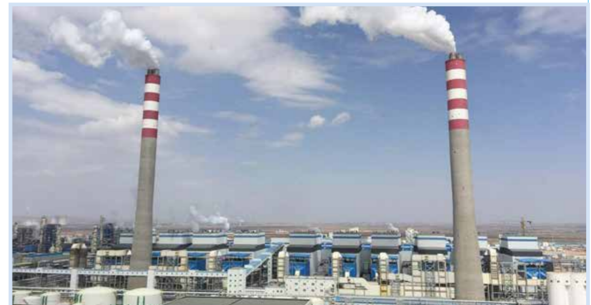
神华宁煤煤制油动力锅炉项目
