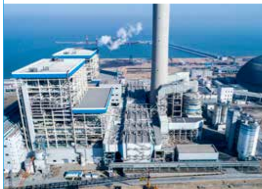
华电莱州二期2X1000MW二次再热项目
