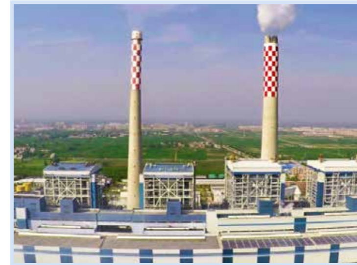
660MW超超临界T型锅炉-安徽田集电厂
