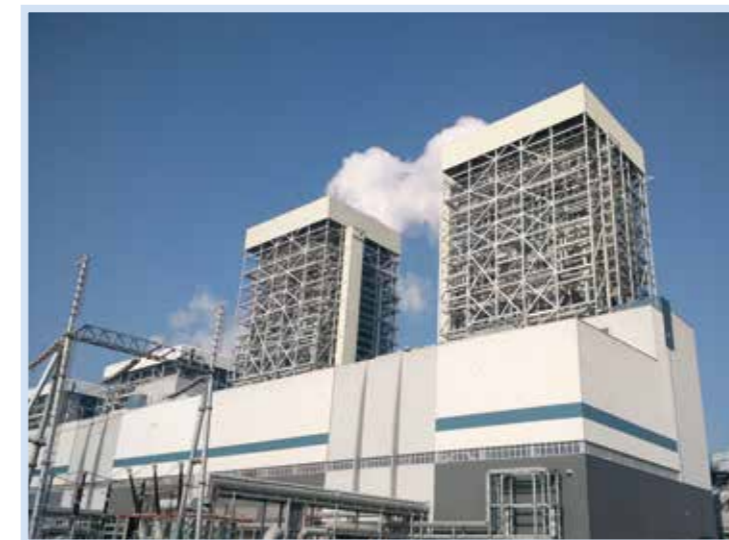
世界首台1000MW超超临界二次再热塔式锅炉-国电泰州电厂二期
