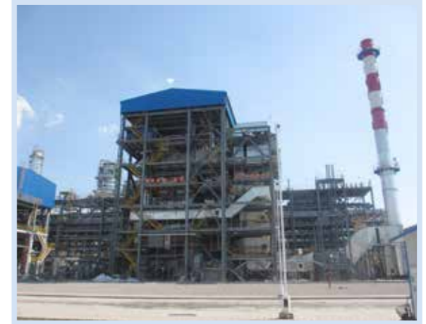
宁夏石化1X130t/h开工锅炉岛项目
